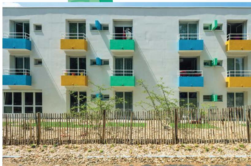
Le foyer logement de Pirmil
